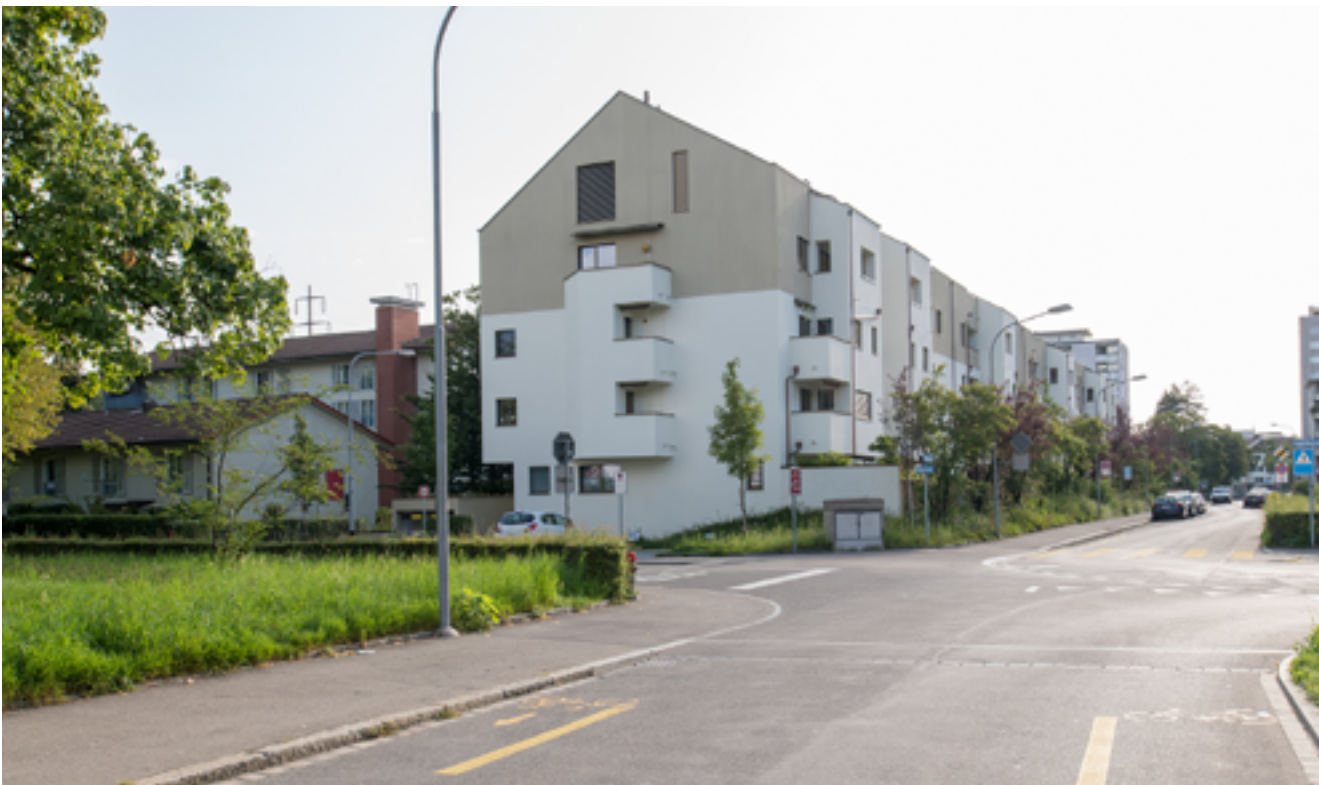
Abb. 41 Blick auf den Bau der Genossen- schaft, sichtbar die Tiefgarage- neinfahrt
