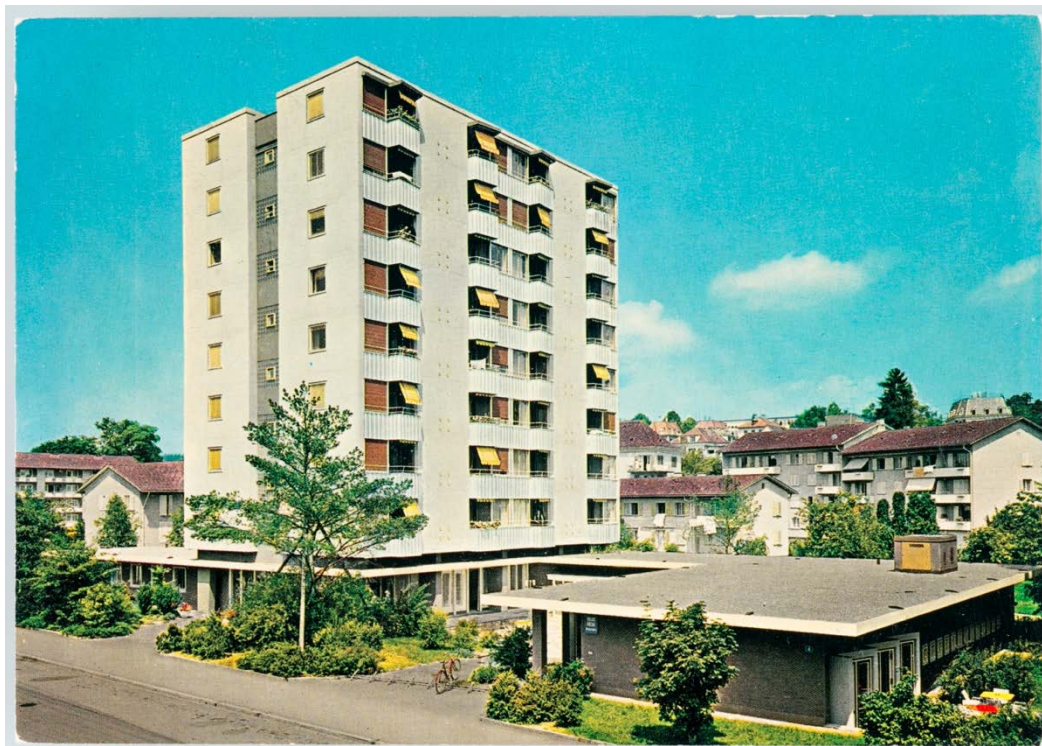
Abbildung 1: Postkarte Alterssiedlung Felsenrain, Quelle: Baugeschichtliches Archiv, Fotograf*in und Datum unbekannt
